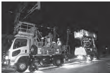
トロリ線取替作業
